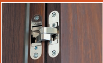
Regulowane trzy zawiasy ukryte (drzwi bezprzylgowe)
